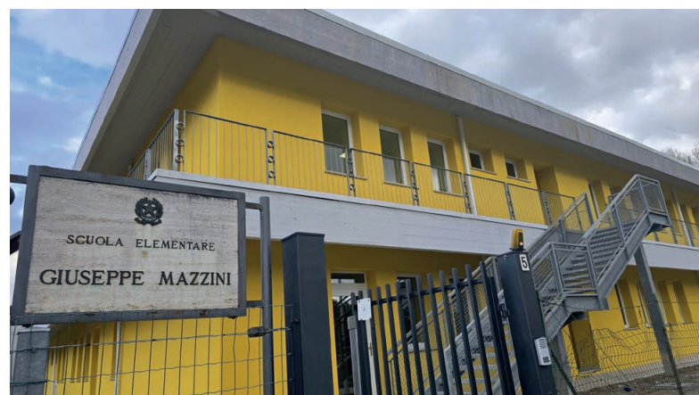
La scuola primaria "Giuseppe Mazzini" ristrutturata
